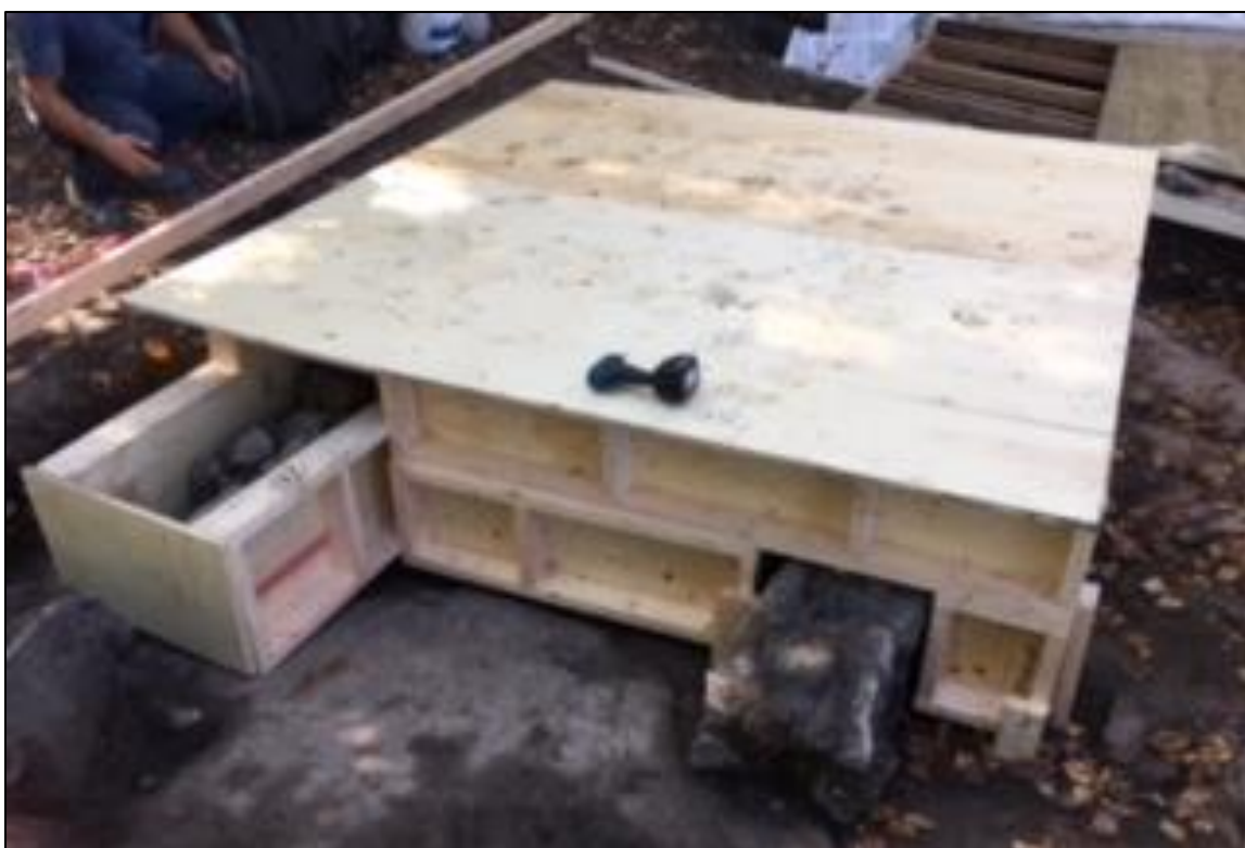
Figure 46 : Détail de la structure de bois sur les vestiges de la base de foyer et des murets latéraux du presbytère. (Photo : M. Tremblay, IMG_8410, 2017-09-20)
