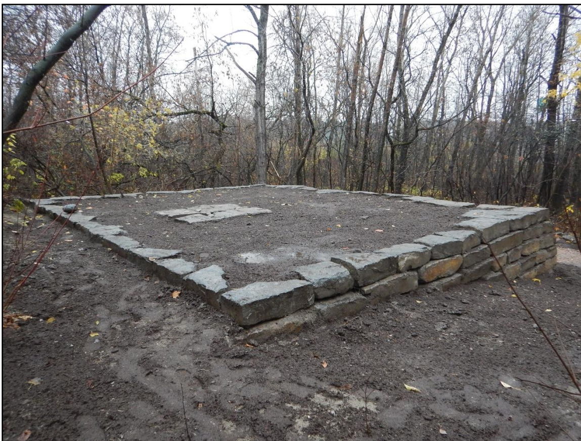
Figure 108 : Évocation de la maison du commis, en voie d'aménagement. (Photo : M. Tremblay, DSCN3149, 2017-10-27)
