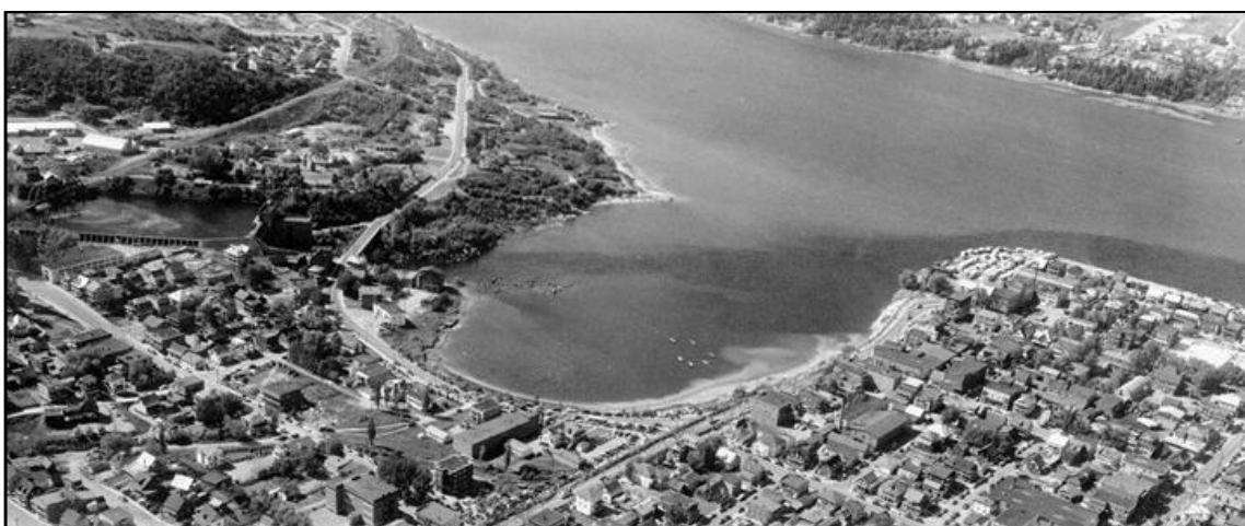
Figure 3 : Vue aérienne du site le 25 octobre 1960, avant la construction du pont Dubuc. (Source : Société historique du Saguenay, FPH-55-011-01)
