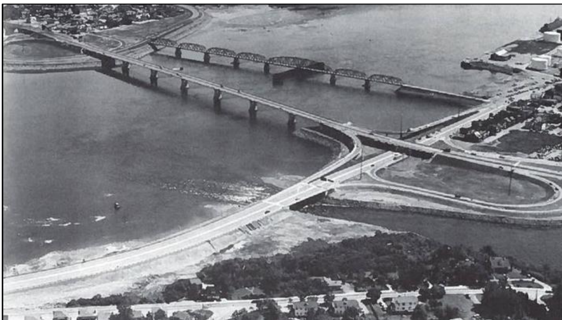
Figure 4 : Vue aérienne du site du poste de traite en 1972, suivant la construction de la prolongation du boulevard Saguenay. (Source : Laboratoire d'archéologie, UQAC)
